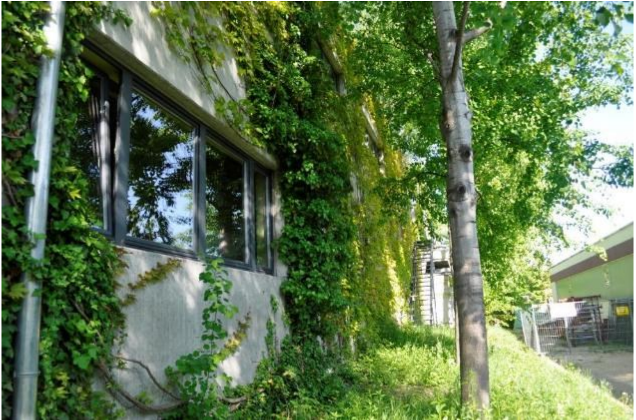
Oben: Selbstklimmende Fassadenbegrünung in Kombination mit Beschattung durch Bäume als Teil eines Gebäudeklimatischen Konzepts beim Fruchthof Konstanz
