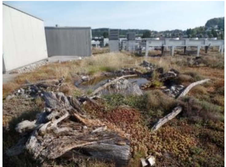
Biodiversitätsfördernde Aufwertung eines extensiven Gründach Foto Bodensee-Stiftung
